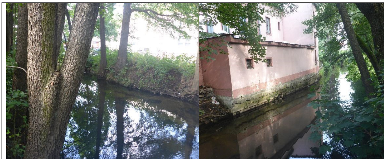
obr. 64: Vlevo – Umístění PPO mezi domem a jezem, vpravo – Umístění PPO mezi domem a tokem
