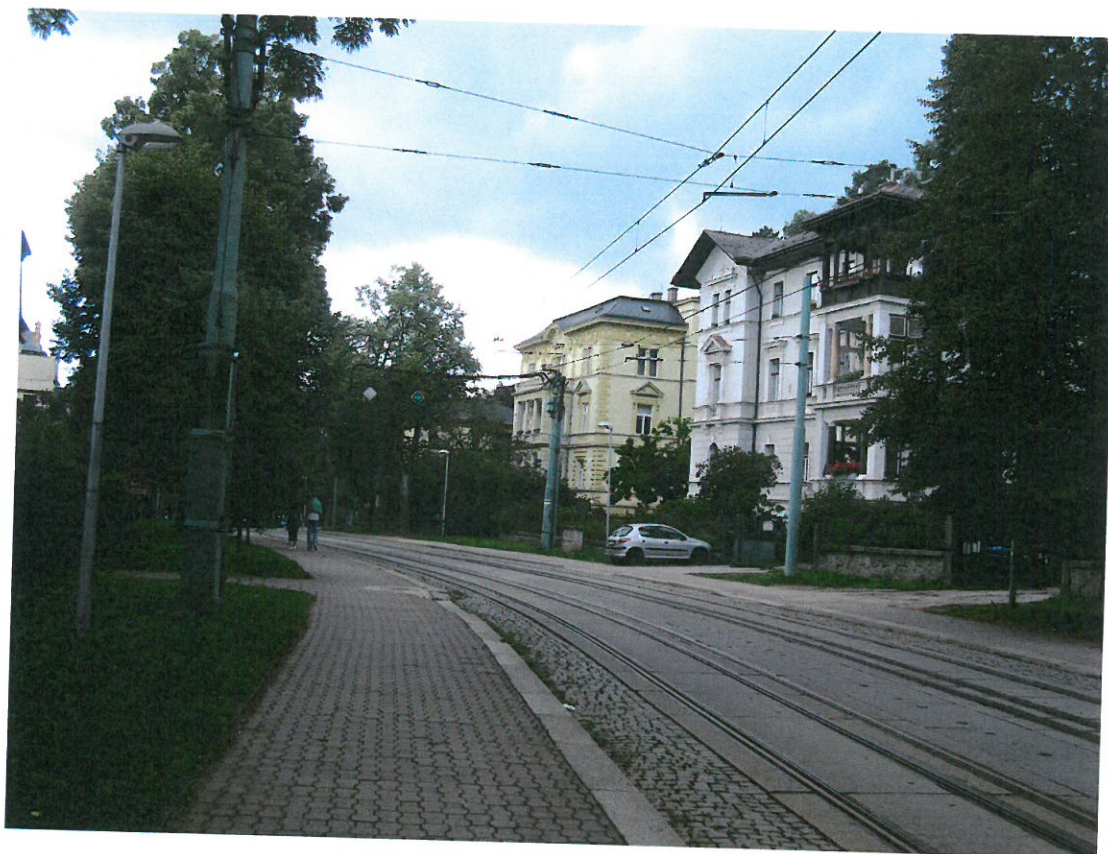
Foto 3 Absence stromů v řadách na úseku A v oblouku ulice. Stromy nahrazují sloupy k uchycení tramvajové troleje. Snímek 6. 8. 2016.
